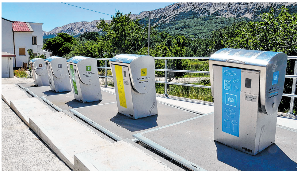
U izgradnju i postavu pet senzorima opremljenih podzemnih setova spremnika za otpad na području Baške i susjednih mjesta Općina uložila više od dva milijuna kuna
